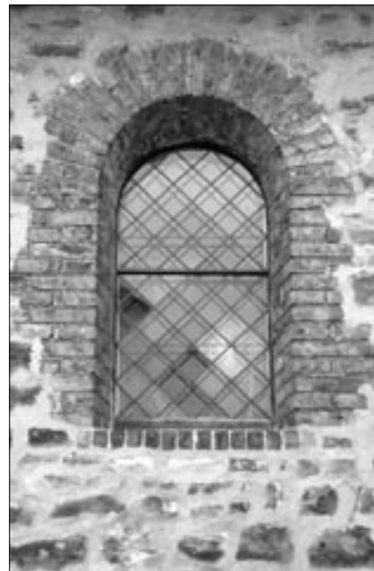
nachträglich vergrößerte Fenster- öffnung mit in Ziegel ausgemau- erten Gewänden
