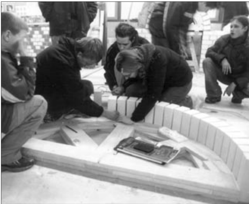
Schüler am Ausrichten eines Bogens am Lehrgerüst
