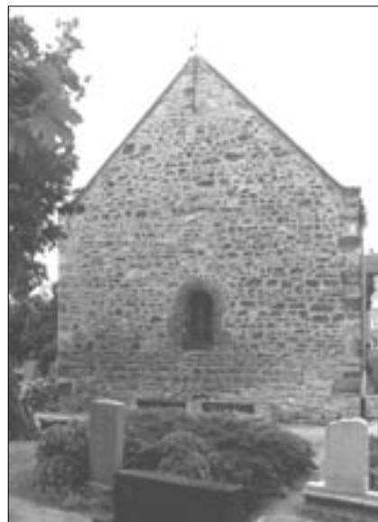
Ansicht von Westen mit Giebel
