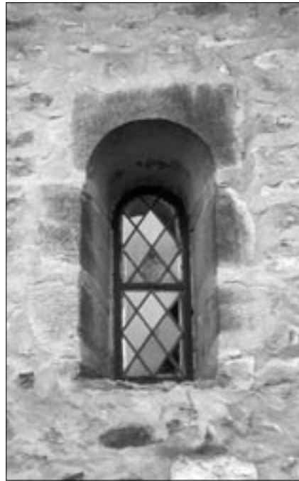
originale romanische Fensteröff- nung, bemerkenswert der aus einem monolithischem Werkstück hergestellte Rundbogen
