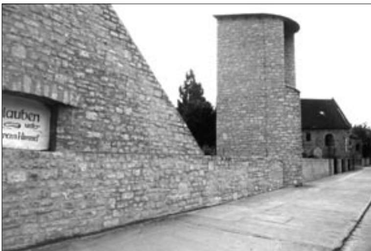
Moderne Ergänzungen: Glockenturm und Friedhofshalle
