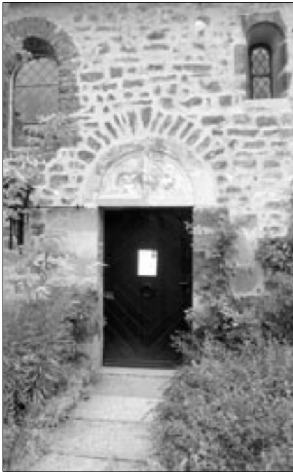
Eingangssituation mit romani- schem Portal und zweierlei Fens- terformaten: einem barocken und einem romanischen
