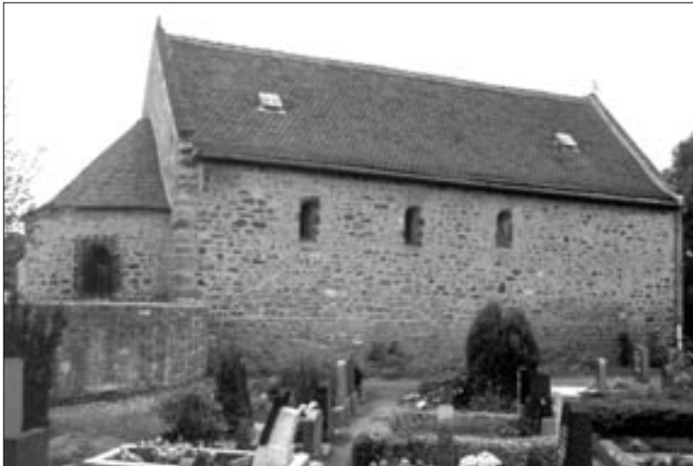
Ansicht von Süden mit originalen romanischen Fensteröffnungen
