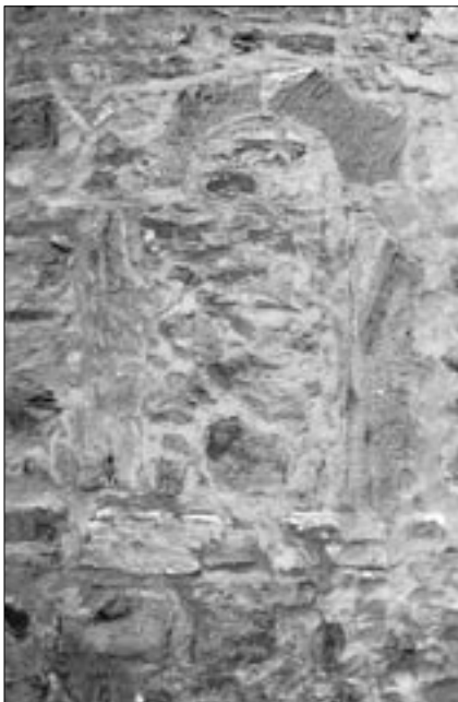
nachträglich vermauerte romani- sche Fensteröffnung im Bruch- steinmauerverband der Apsis
